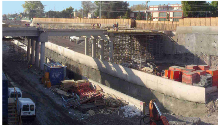
Fig. 9 Proceso constructivo en pasos a desnivel de la autopista Américo Vespucio Sur en la ciudad de Santiago de Chile (Foto gentileza de Pilotes Terratest Chile)
