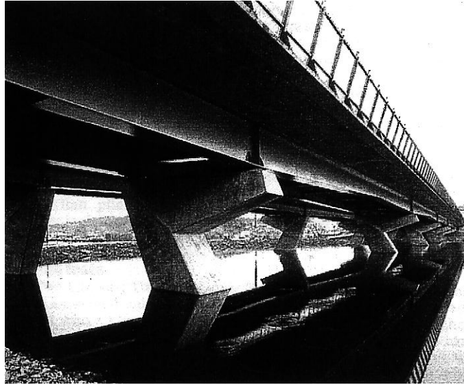
Fotografía 2. Vista general del puente Vårby.
