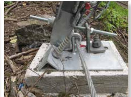
Además, las vallas se deben pretensar en paralelo y perpendicularmente mediante cables. Para evitar que se transmitan cortantes al micropilote se recurre a un gancho de cable flexible (cabeza FLEX, fuera del catálogo de productos ISCHEBECK) que puede atornillarse al micropilote TITAN.
