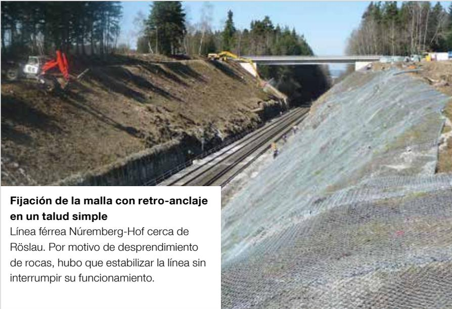
**Fijación de la malla con retro-anclaje en un talud simple**
