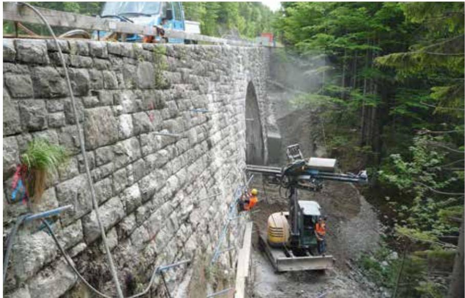
Con el **método ISCHEBECK** se perfora directamente con las barras TITAN, con una boca de perforación que queda perdida, y la estabilización del orificio de perforación se consigue gracias a la inyección de la lechada de cemento.
