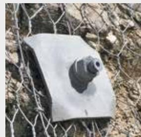
Ejemplos de placas de garra de los fabricantes de malla, con tuercas esféricas TITAN galvanizadas.
