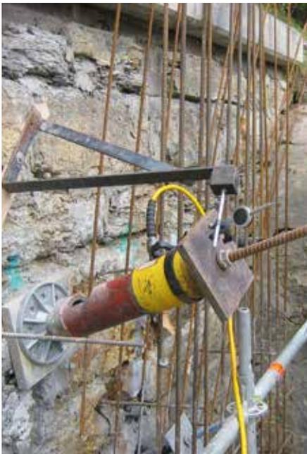
Es imperativo asegurar que no haya transferencia de carga entre el bulón y el revestimiento exterior.
