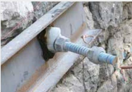
Inicialmente se estabilizó el muro atando las barras TITAN mediante vigas de reparto para distribuir la carga. La compensación de inclinaciones se puede conseguir mediante la placa de cabeza y el disco compensador TITAN.
