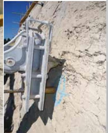
Evolución por etapas de excavación y estabilización, dependiente de la estabilidad de la pared de suelo excavado (en general cada 1 - 2 m). La excavación puede proseguir una vez que el retro-anclaje se haya completado y el hormigón proyectado haya fraguado.
