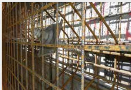
Una segunda placa de cabeza, sujeta mediante dos tuercas esféricas, puede quedar integrada entre las capas de armado.
