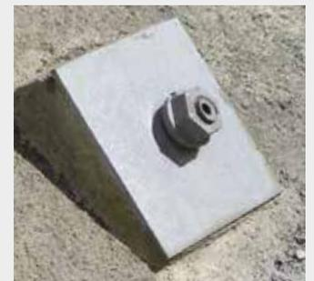
Otro método de compensación usual en obra es la inserción de una cuña de mortero bajo la placa de cabeza.
