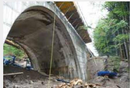
Finalmente, el muro quedó solidariamente unido y anclado mediante las barras TITAN al revestimiento de hormigón in situ.
