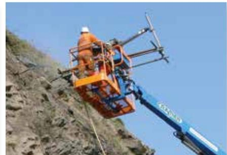
La instalación de las barras TITAN puede realizarse con excavadora+mástil de perforación, desde el pie del talud o sobre la plataforma de coronación.
