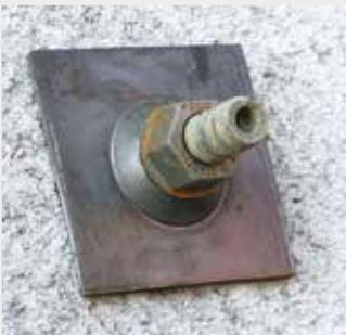
La placa de cabeza TITAN puede compensar desviaciones de inclinación con respecto al estribo de aprox. 5°.
